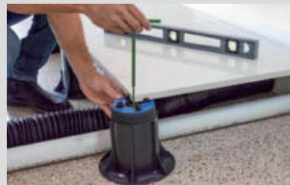
Erhältlich in fünf Größen/Höhenbereichen für 3 mm breite Fugen
